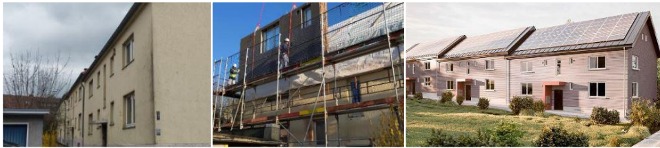
Serielle Sanierung von drei Wohnhäusern aus den 1930er-Jahren in Hameln mit vorgefertigten Elementen. Die Installation eines Dämmelements dauerte lediglich 20 Minuten. © ecoworks
