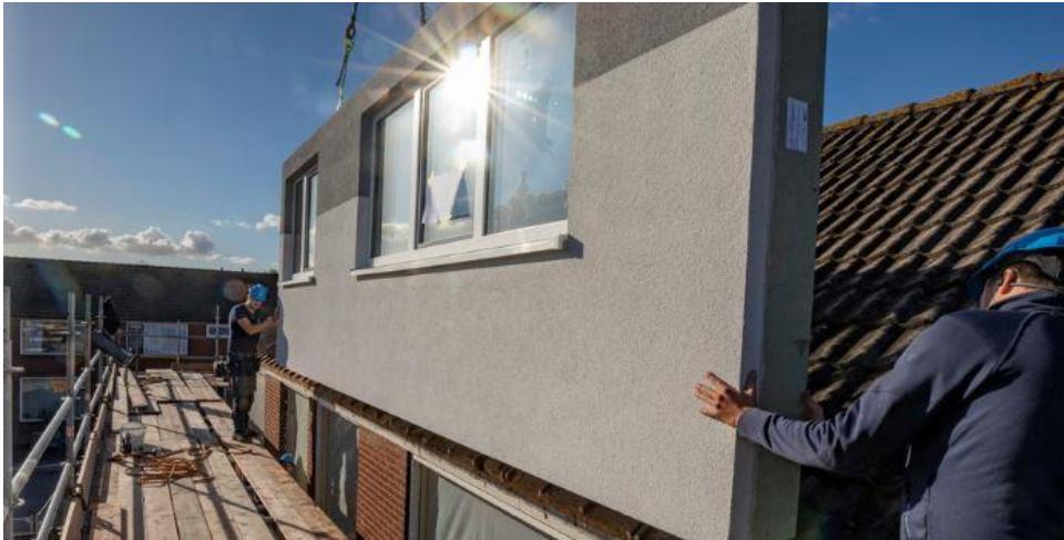
Serielle Sanierung von 194 Reihenhäusern in der Provinz Zeeland, Niederlande, mit vorgefertigten Elementen. Das spart Bauzeit und Baukosten. © Bouwbedrijf Joziasse
