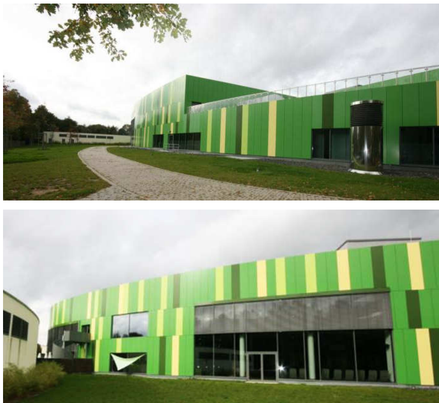
Abbildung 3: Außenansichten Bambados: Ost, Südost
